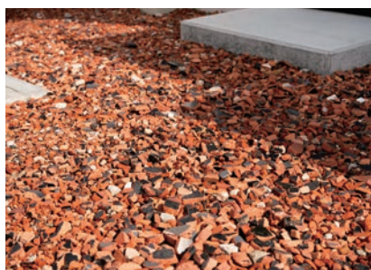
コンテナの客室の周辺には、震災で発生した能登瓦などの廃材を再生したチップが敷き詰められている。
